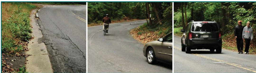
La vía existente presenta deterioro en el pavimento y drenaje deficiente y carece de seguridad para ciclistas y peatones.
