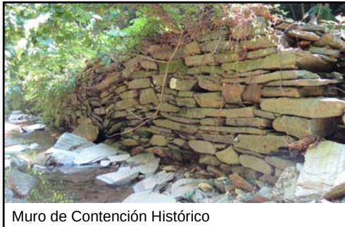
Muro de Contención Histórico
